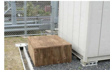
昨年、寒冷期に、井戸用ポンプが凍結し、動かなくなりました。再稼働させるのに、呼び水をしたりして大変な思いをしました。今冬、凍結対策として、木の枠を取付て全体を覆い、冷気が直接あたらないようにしました。これで給水の心配がなくなればと思います。
